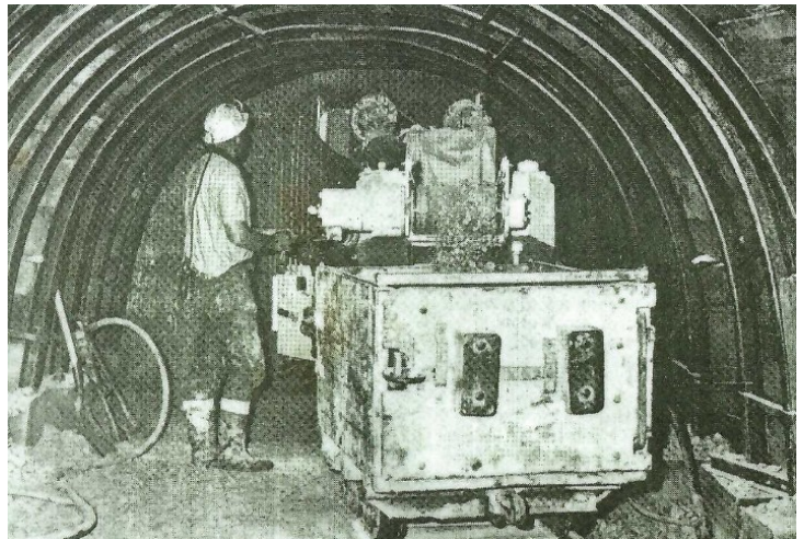
Una cara de treball en una de les mines de Kingsteignton de Watts, Blake, Bearne & Company, als anys setanta, que mostra un carregador de ploma Westphalia que omple un sol 12 cwt. Camió. Això hauria estat impulsat per l'home fins a l'adit principal de transport.
